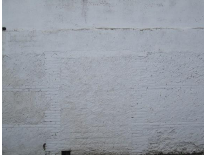
Vestigios del acceso a la fosa común de soldados marroquíes del cementerio de Castellón desde la carretera exterior al muro del recinto
